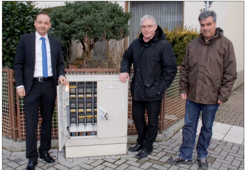
Begutachteten vor Ort einen sanierten Verteilerschrank (v. l.): Jochen Wallenwein, Geschäftsführer von Evus sowie Prokurist Dipl.-Ing. Volker Kreuzer, Leiter Technik, und Elektromeister Peter Herdel von den Stadtwerken Dreieich.
