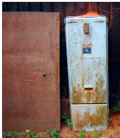
Bild 4: Versiegelter Kabelverteiler vor und nach der Bearbeitung
