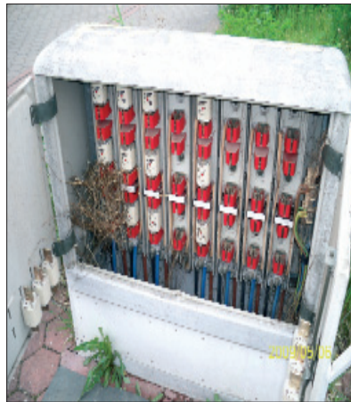
Bild 6: Kabelverteilerschrank vor und nach der Innenreinigung
