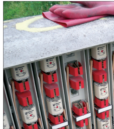
Bild 6: Kabelverteilerschrank vor und nach der Innenreinigung
