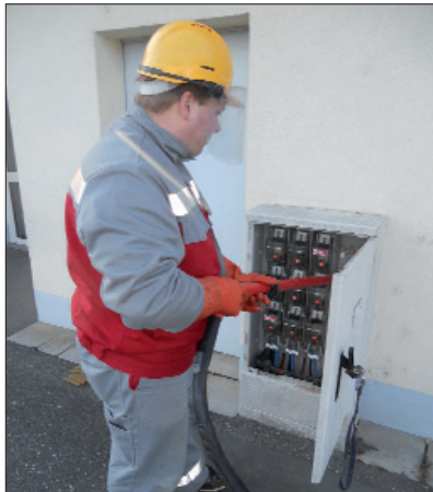
Innenreinigung eines Kabelverteilerschranks
