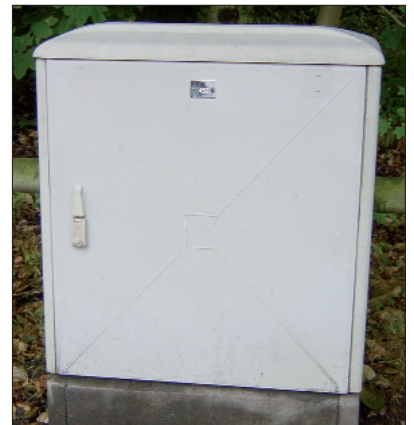
Bild 3: Kabelverteiler nach der Grundreinigung
