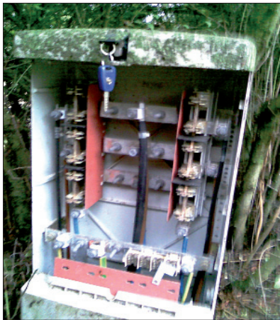
Bild 5: Kabelverteiler vor der Innenreinigung/Inspektion
